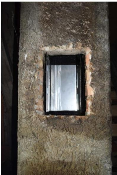
3. Wenn benötigt: Metallischen Abscheidereinsatz im Abgaskanal platzieren.
