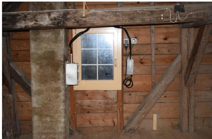
8. Kabel mit Reserveschlaufe verlegen. Demontage für Reinigungsarbeiten nötig.
