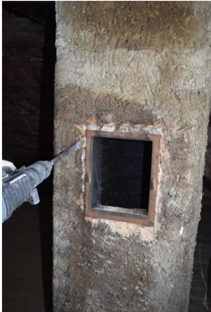
1. Öffnung in Mauerwerk stemmen bzw. Mauerwerk aufbrechen.
